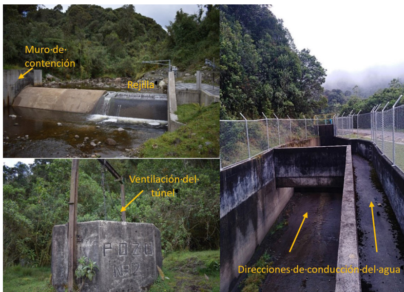
Figura 2. Infraestructura de los pozos y las captaciones del sistema Chingaza
